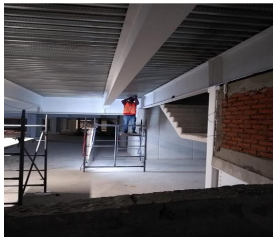
Trabajos en sótanos
