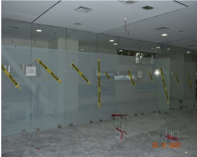
Colocación de cancelería interior
