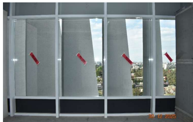
Instalación de cancelería perimetral
