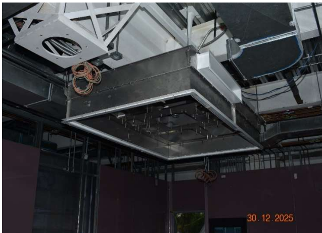
Instalación del gabinete de flujo laminar
