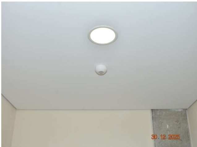
Instalación de luminarias y sensores
