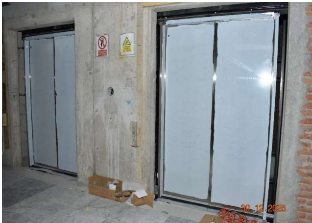
Instalación de puertas de elevadores
