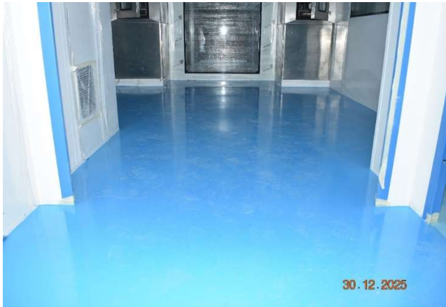
Preparación para recibir piso epoxico en central de mezclas
