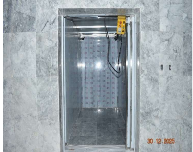
Colocación de mármol en cubos de elevadores
