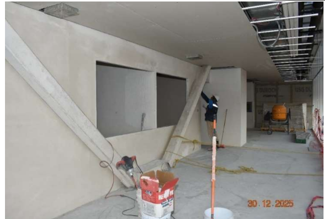
Instalación de muros en farmacia
